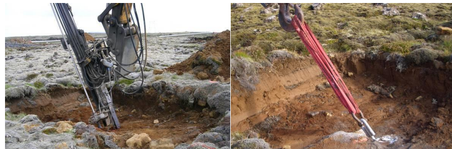
Mynd 5.4 Til vinstri sést hvar borað er fyrir bergbolta. Myndin til hægri sýnir prófun á bergbolta.
