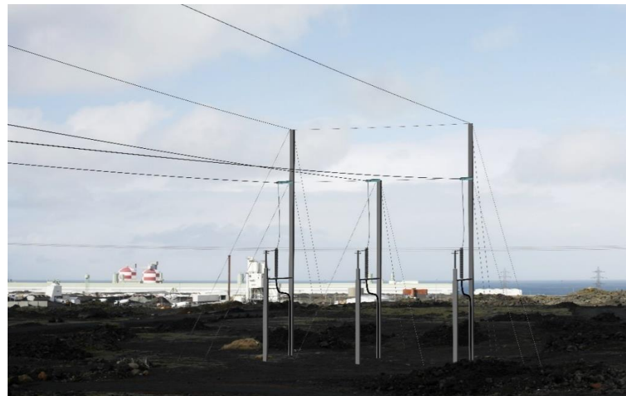
Mynd 6.19 Líkanmynd af strengendamastri svipuðu og gert er ráð fyrir að rísi við Hraunhelli.
