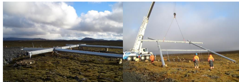
Mynd 5.5 Myndin vinstra megin sýnir samsett mastur. Hægra megin sést kranabíll reisa mastrið. Myndirnar eru úr línunni á milli Reykjanesvirkjunar og aðveitustöðvar við Rauðamel.
