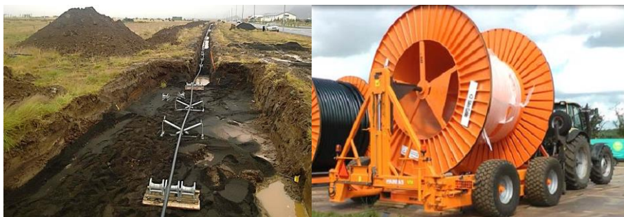
Mynd 5.8 Útdráttur háspennustrengja í opinn skurð.
