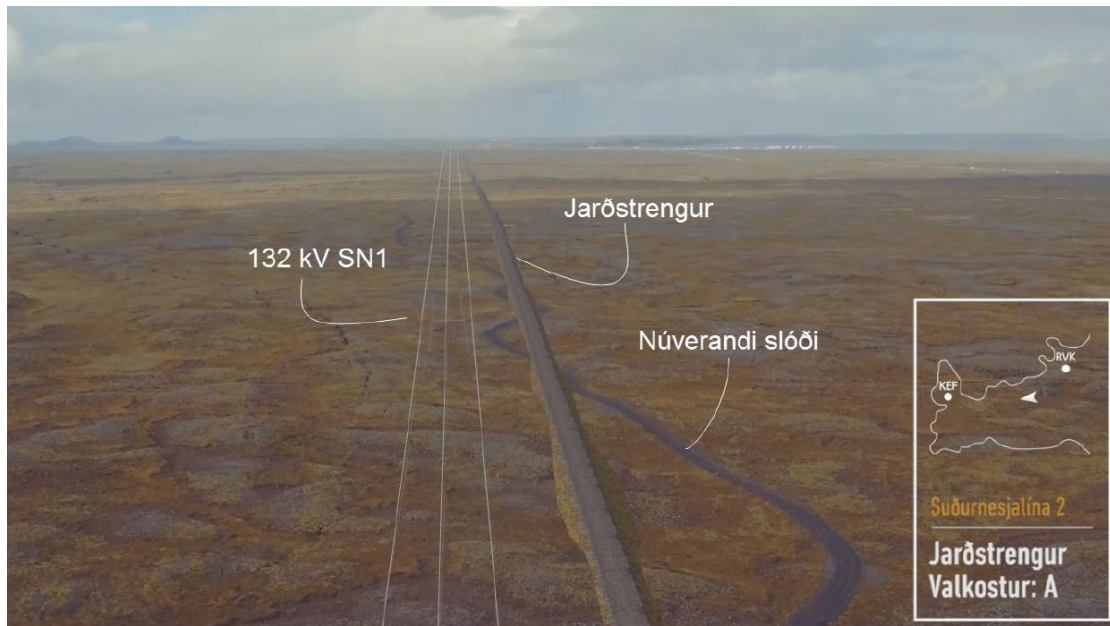
Mynd 5: Mynd 25 Möguleg útfærsla á jarðstreng samsíða Suðurnesjalínu 1 þar sem slóði er lagður að hluta yfir jarðstreng i verklok (Landsnet, 2016).
